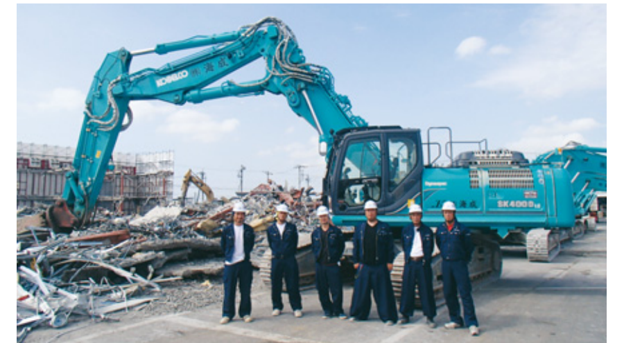
巨大な重機を操り、ビルや施設等の解体業務に取り組むプロ集団です。常に安心・安全の工事を心掛け、建物総合解体業者としてお客様から高い評価をいただいています。
